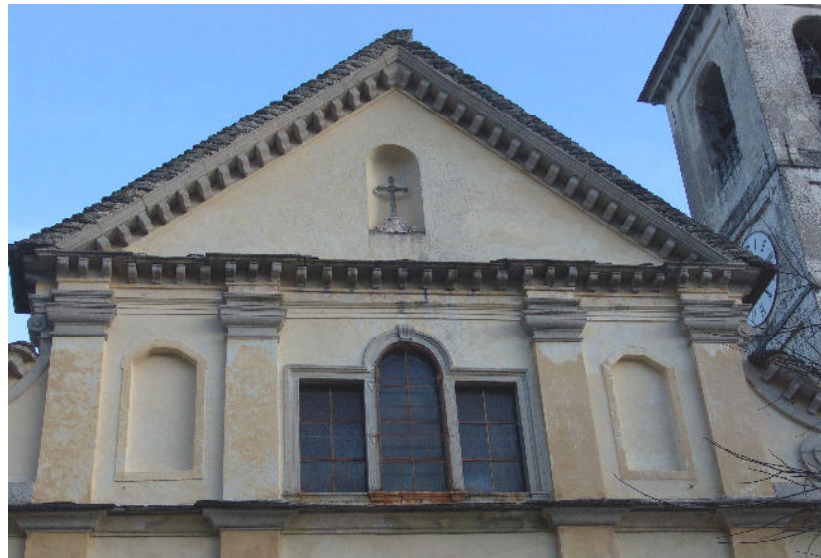
Cornici, capitelli e serliana in serizzo facciata della chiesa di Vocogno (Valle Vigezzo)
